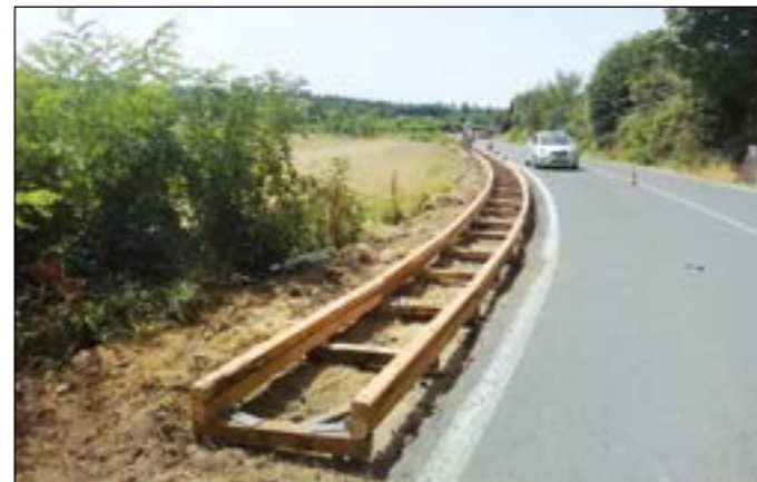
Fase di realizzazione (curva)
