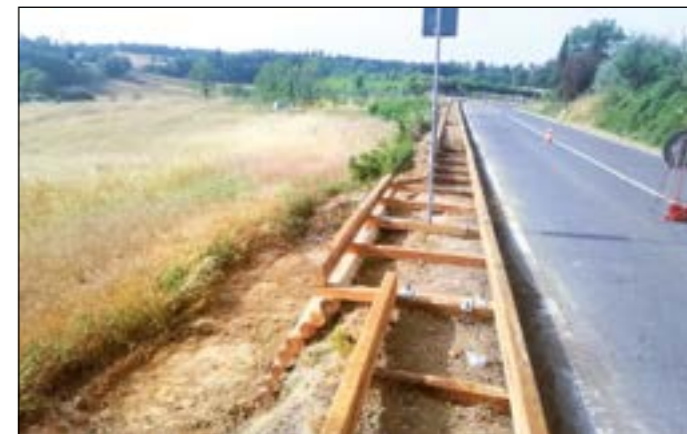
Fase di realizzazione (con piazzola di fermata Bus)
